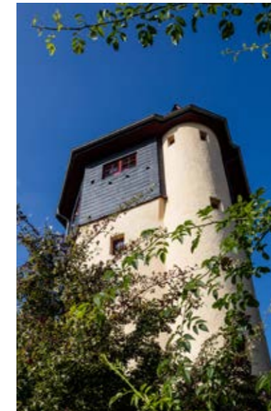
Wasserturm, Bad Soden a. Ts.
